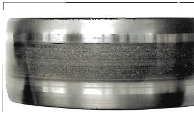
Fotografia 7-15-3 Część: Pierścień wewnętrzny łożyska walcowego Symptom: Na powierzchni bieżni pojawia się korozja w kształcie pasa z towarzyszącą mu korozją punktową
