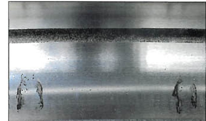
Fotografia 7-16-2 Część: Pierścień zewnętrzny pierścienia obrotowego. Symptom: Rdza na powierzchni bieżni w odstępach kulek. Przyczyna: Kondensacja wilgoci podczas okresów postojowych.
